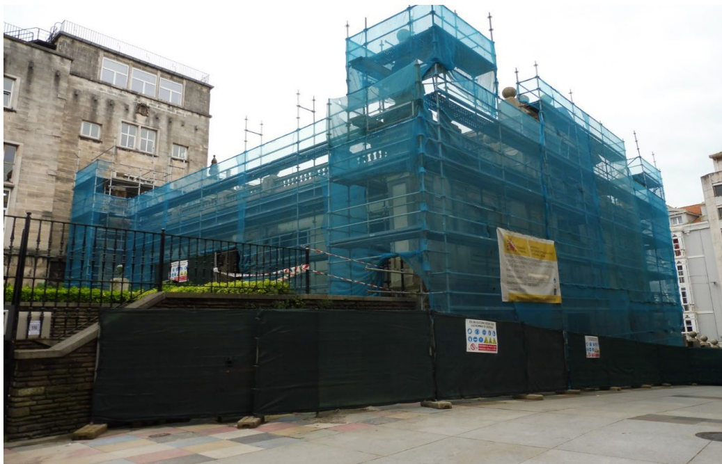
Figura 1. El edificio en obras
